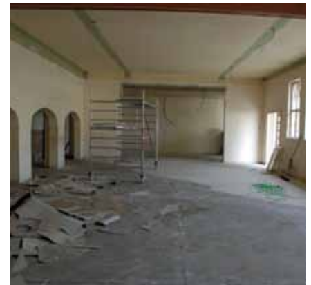
Vor 60 Jahren wurde das Pfarrheim erbaut - nun wird es einer Generalsanierung unterzogen und dem heutigen Standard angepasst.
