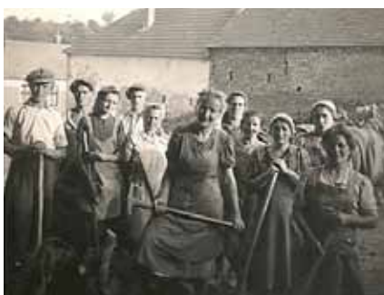
Auch viele Frauen beteiligten sich an den Bauarbeiten
